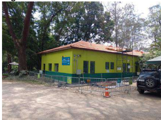
Figura 144: Reforma do telhado da CECCO
