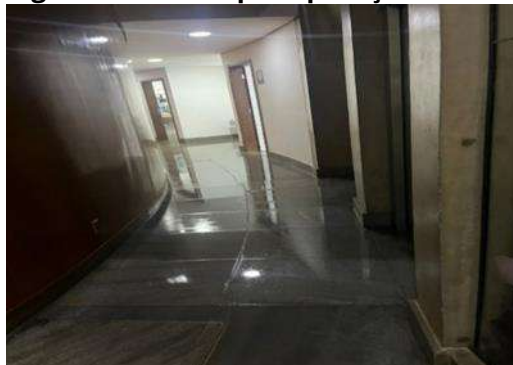
Figura 142: Piso após aplicação de cera
