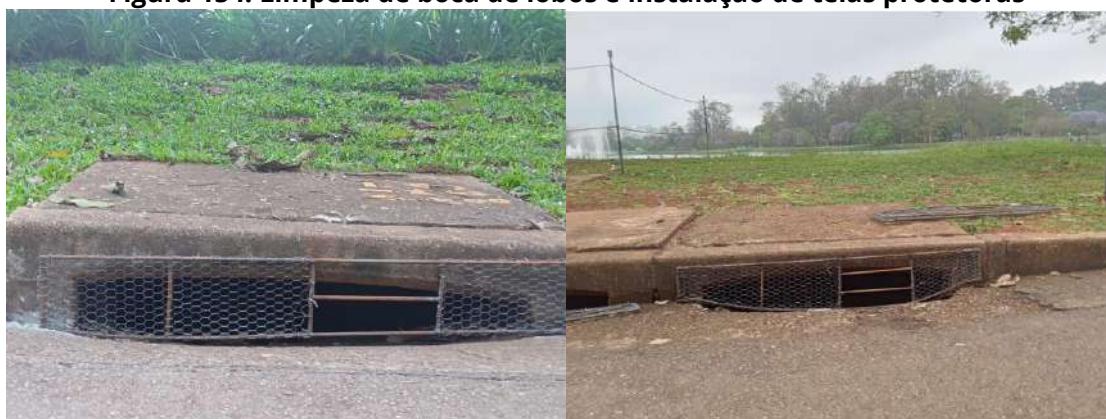
Figura 154: Limpeza de boca de lobos e instalação de telas protetoras
