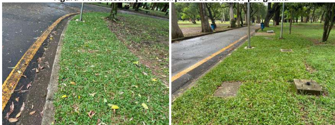
Figura 147: Substituição de calçadas de concreto por grama
