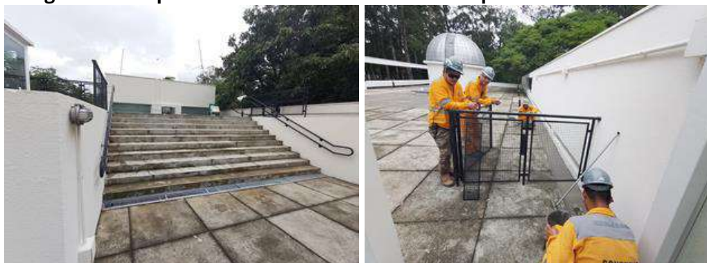
Figura 157: Reparo na cobertura da Escola Municipal de Astrofísica - EMA
