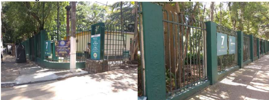
Figura 146: Pintura e reforma de muretas e gradil perimetral
