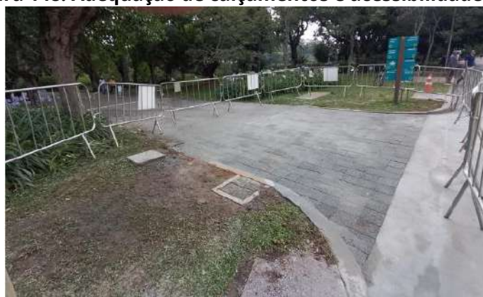
Figura 148: Adequação de calçamentos e acessibilidade
