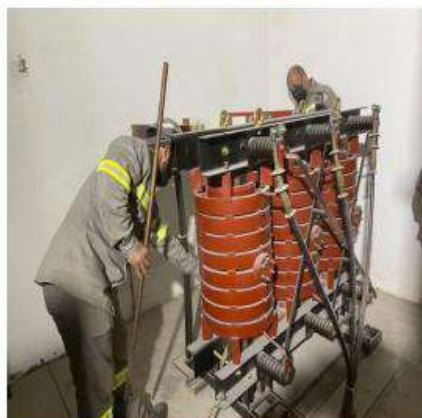
Transformador danificado
