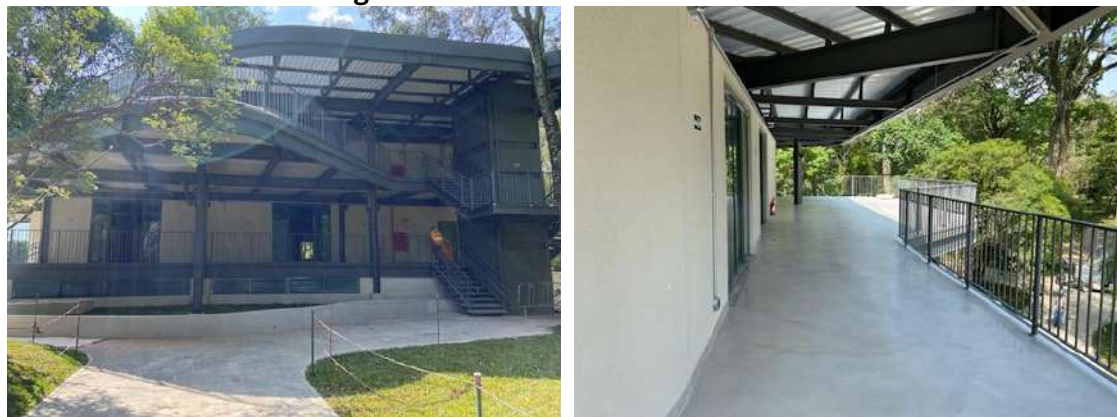
Figura 150: Reforma em andamento
